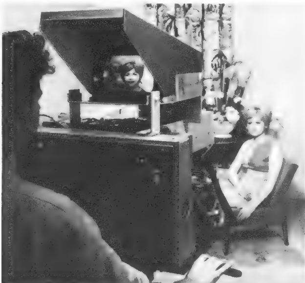
Versuchs-Farbfernsehkamera von Marconi mit drei 4 1/2-Zoll-Orthikon-Bildaufnahmeröhren
